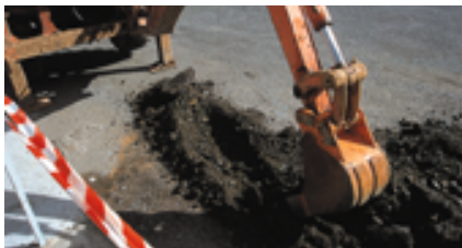
1. Abrir una zanja o un espacio.
