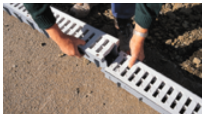
5. Armar los elementos dejando forzosamente las rejillas atornilladas en la canaleta.
