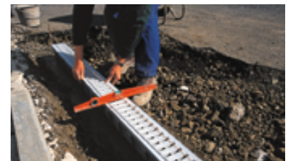
6. Nivelar ligeramente por debajo de la superficie terminada.
