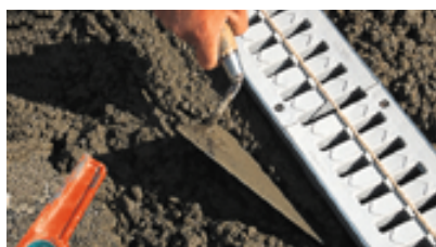
8. Rellenar con cemento de la mezcla apropiada en cada costado hasta la superficie de la canaleta.
