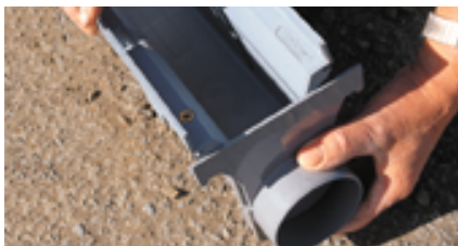
4. Ensamblar los accesorios en las canaletas.
