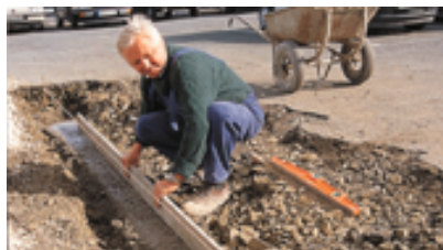
2. En el fondo aplicar una capa de cemento con la mezcla apropiada para las condiciones de instalación.
